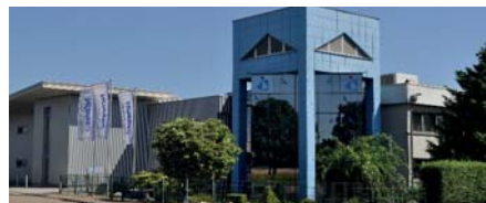
Bahlingen a. K.: Hauptsitz des Unternehmens, Formenbau
